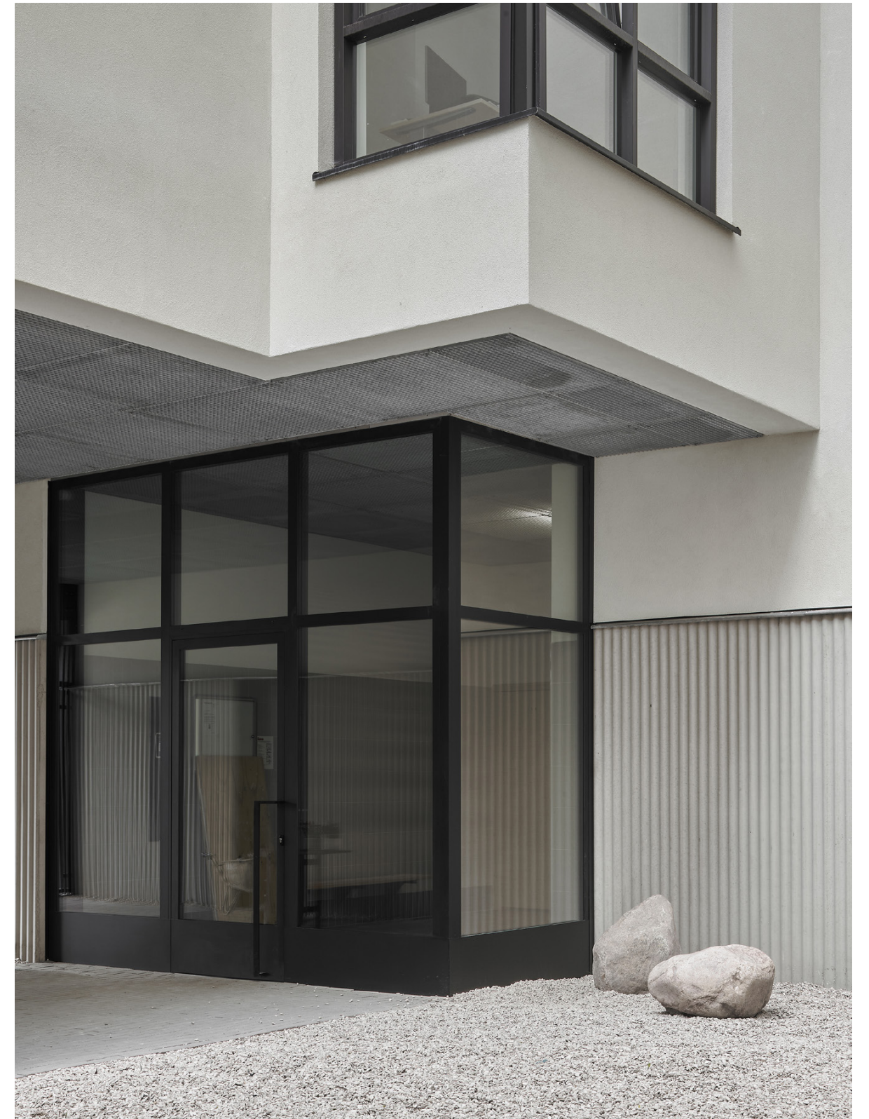
Hoekramen voorzien de entreehal en een deel van de compacte appartementen van extra daglicht en diagonaal uitzicht op de smalle binnenhof. De doorlopende materialisatie benadrukt het collectieve karakter en continuïteit van het publiek interieur.
