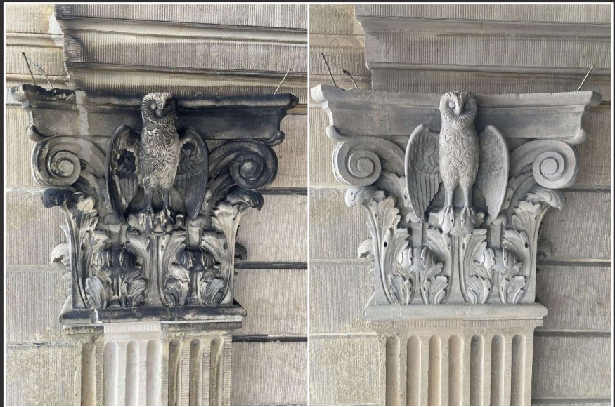
Vervuiling verwijderd dmv lasertechniek
