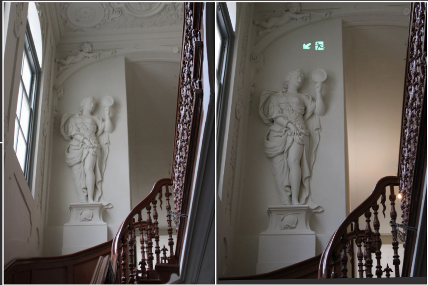
Noodverlichting: weggewerkt in de wand en alleen te zien bij een noodsituatie
