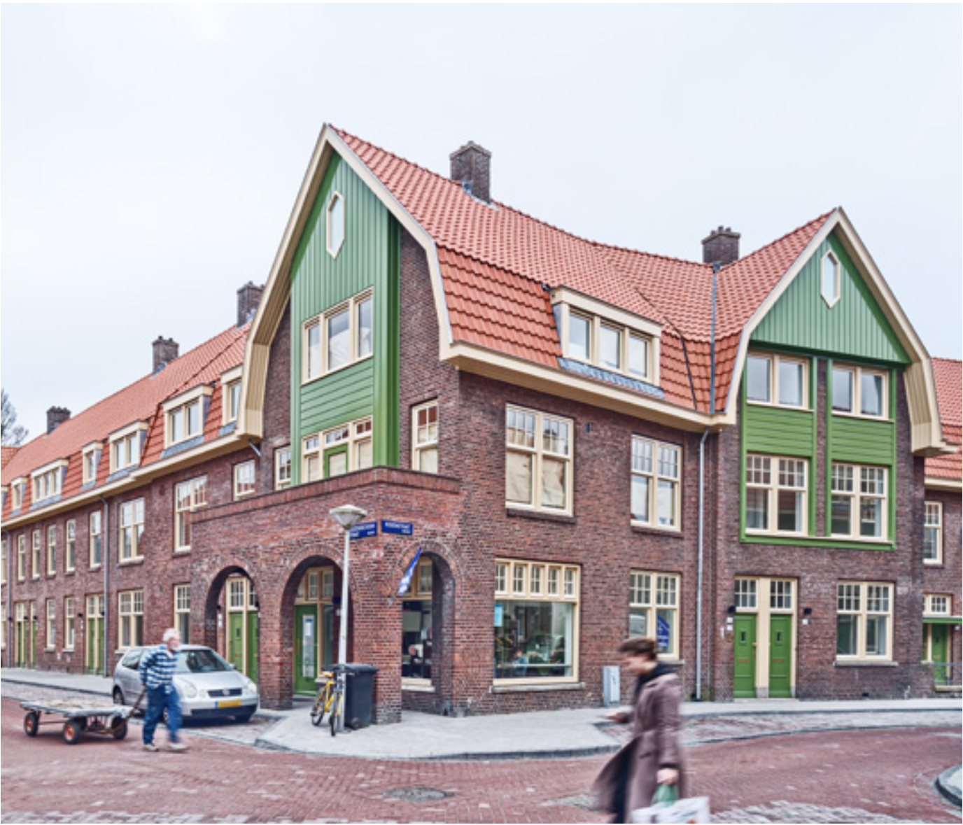
Blok 8 - Hoek Reserdastraat en Duizendschoonstraat
