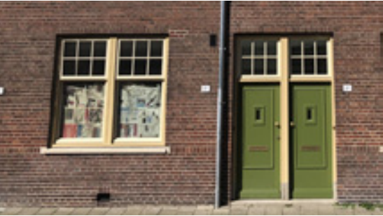
Fig. 4A13 - Links een breed-hoog kozijn met een bovenlicht met schijnroeden
