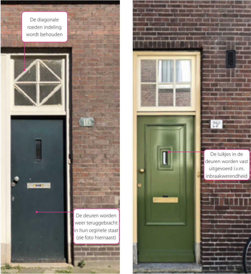
Fig. 4A.1 - Huidige staat straatdeurkozijn met decoratieve diagonale roeden 29 april 2020 Richtlijnen buitenschil woningen Gentiaanbuurt Blok 6 t/m 10 - Deel I Blok 6 & 7 9
