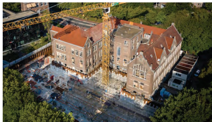
Uitvoering van de parkeerkelder en de uitbreiding, 2020
