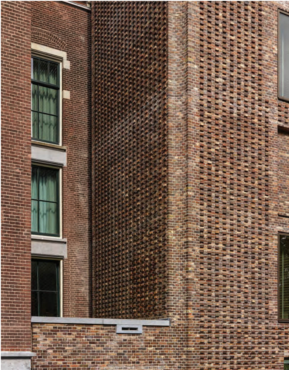
Metselwerk met reliëf in de nieuwe uitbreiding
