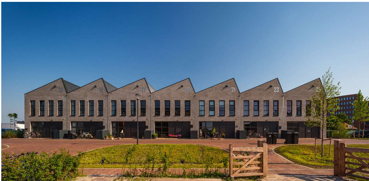
Loodswoningen aan de dijk
