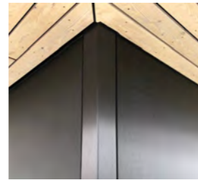
De onderzijdes van de vloerbanden en balkons zijn bekleed met hout. PV-panelen in de gevels (en dak, in totaal 1500 m 2 ), en in de niet-zonbelaste gevels zijn Matelac-panelen geplaatst; het verschil is nauwelijks te zien.
