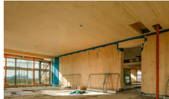
Plafonds en wanden van hout
