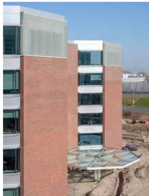
Nieuwe entree, gevel en toplaag met glazen bouwstenen
