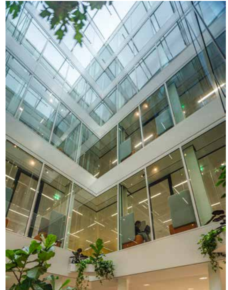
Lichthoven brengen daglicht diep het gebouw binnen
