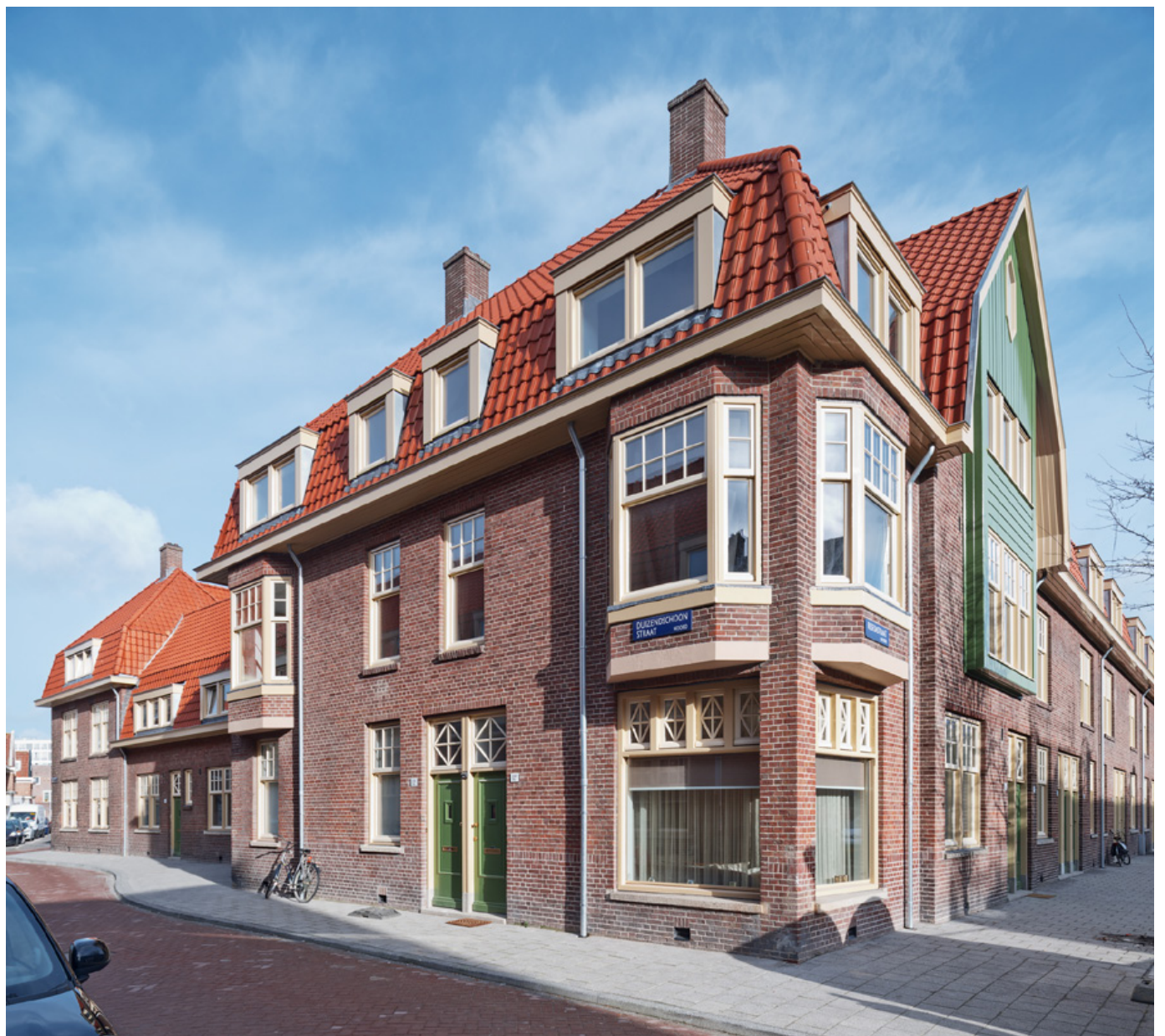
Bij de renovatie is de markante hoek met etage tot in detail teruggebracht
