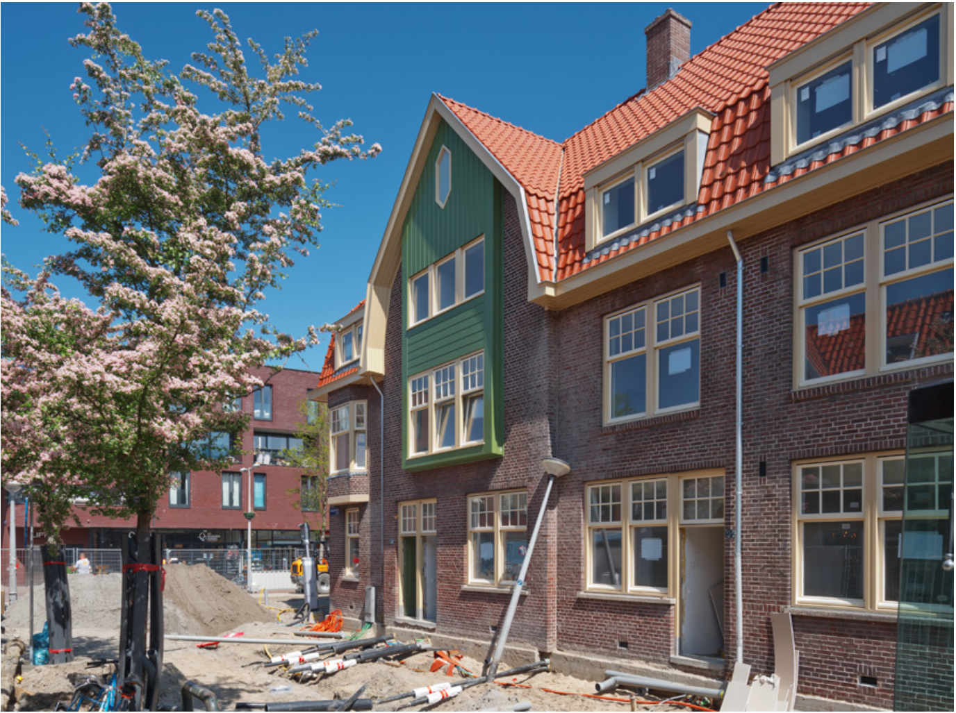
Renovatatie Blok 7 de aansluiting op het stadswarmtenet is in volle gang
