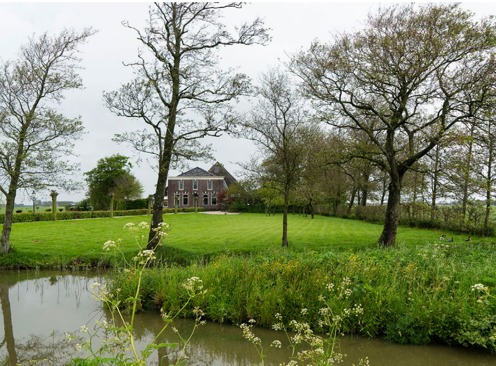
Stolpboerderij De Stins vormt een markant silhouet in het open landschap van Hollands Kroon. De stolp met voornaam voorhuis is ruim gelegen met rondom erfsloten, hoge windsingels en een brede erfsloot. De vrije doorzichten en zachte walkanten laten het erf soepel overgaan in het landschap. Foto: Anna Groentjes.
