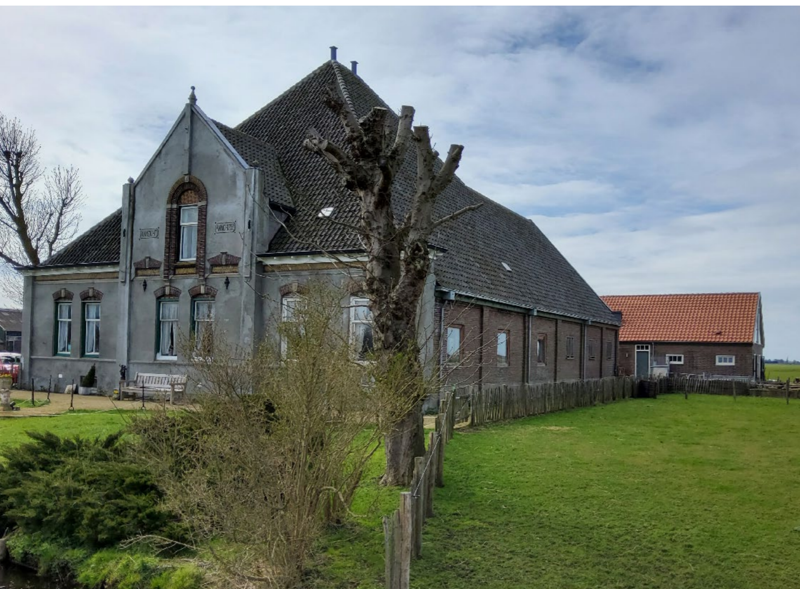
Deze stolp aan de Kanaalweg in Landsmeer is een opvallende verschijning door de gestuukte en rijkgedecoreerde gevel. In combinatie met de sobere zijgevel is de stolpenlogica duidelijk afleesbaar. Foto: MOOI Noord-Holland.
