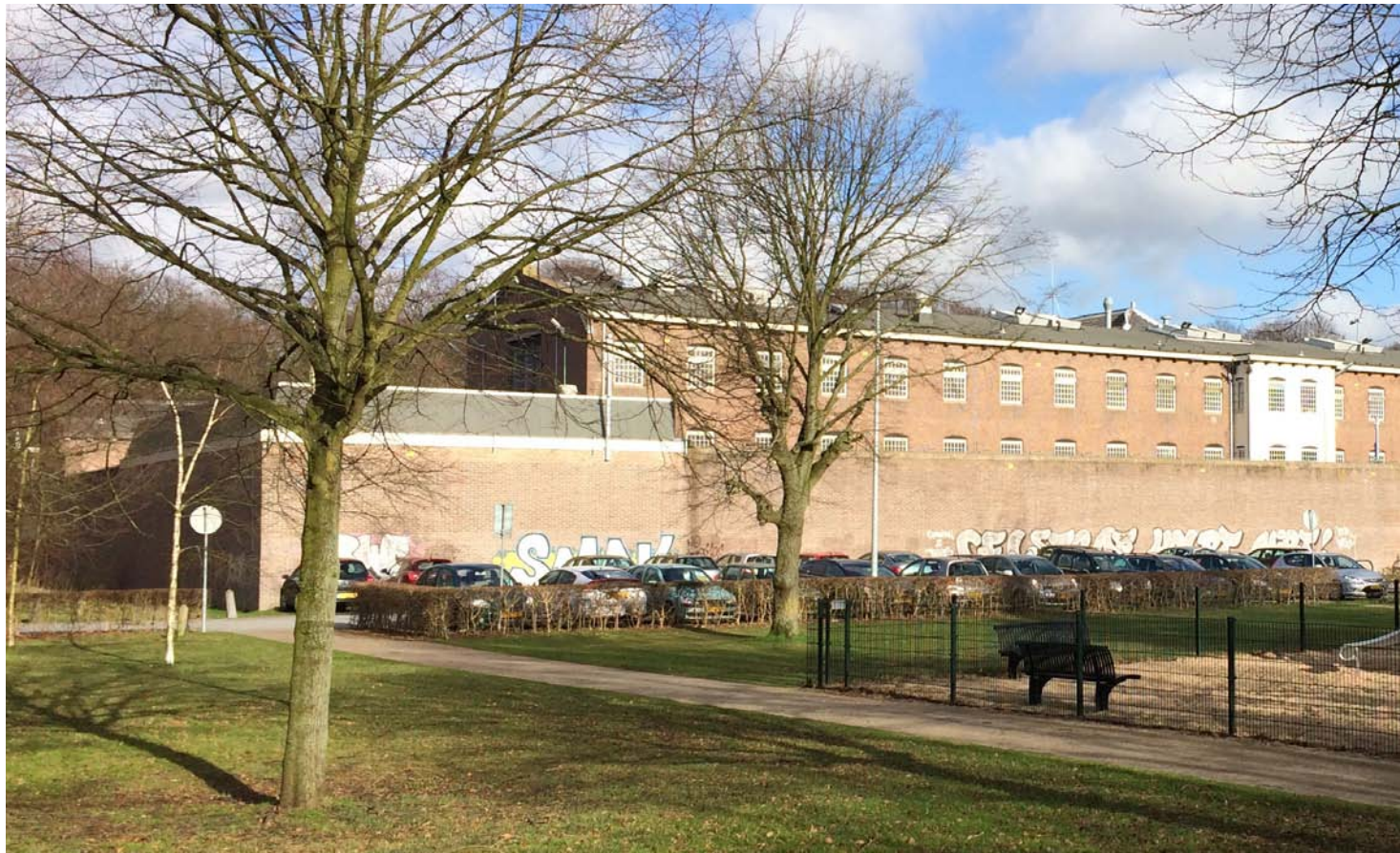
ZUIDWESTZIJDE VOOR INGREEP (BLINDE OMMURING EN GYMZAAL SLUITEN GEBOUW AF)
