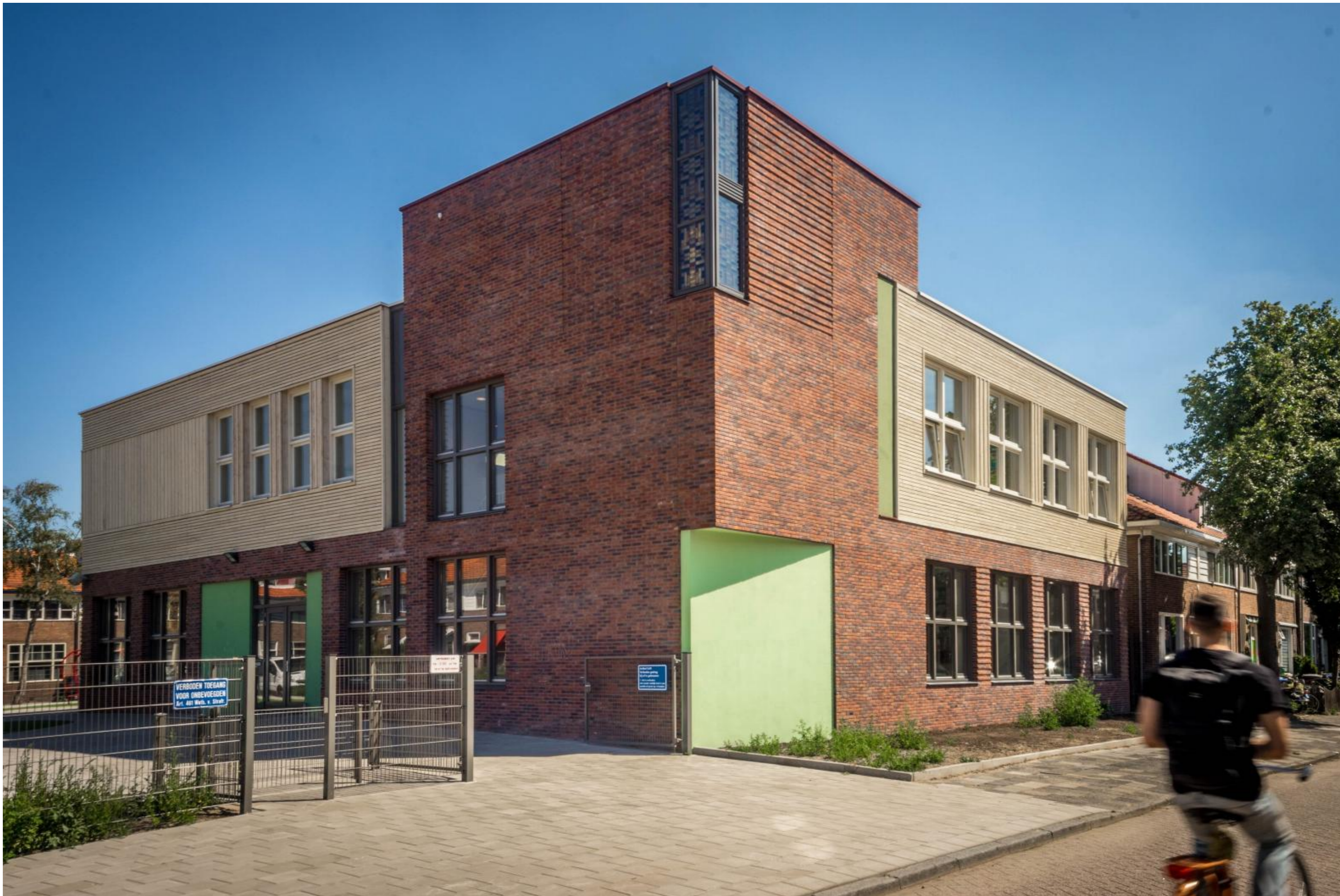
Nieuwbouw CBS Tamarinde - Zaandam
