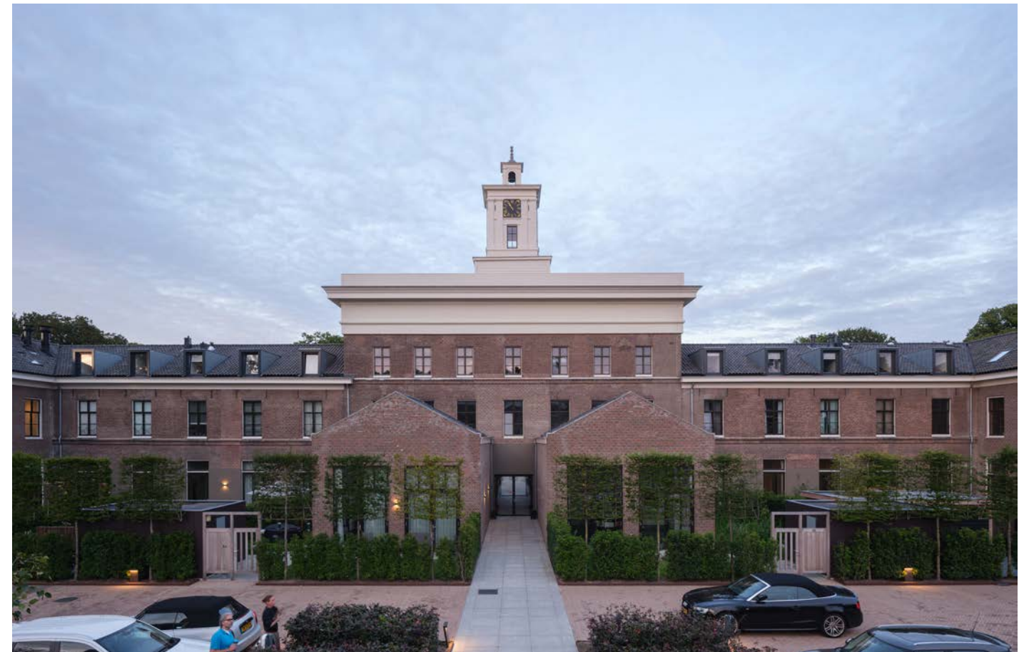
foto binnenterrein richting Oost - voormalig hoofdgebouw, nu twee woningen rondom lichthoven
