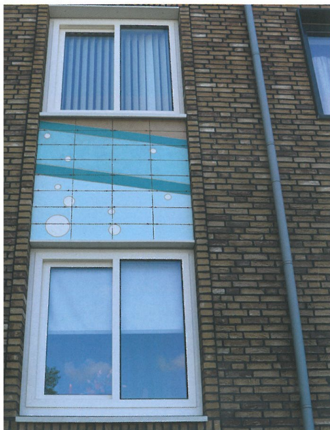
Op de vlakken tussen de kozijnen zijn geglazuurde tegels verlijmd.
