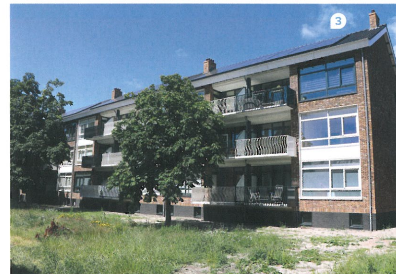
1 // De kopgevel wordt ingevuld met een kunstwerk van keramische tegels. Ondergrond is een stuc laag op het nieuwe metselwerk. 2 // Het tegelwerk is niet alleen 3D, maar bevat ook een reliëf. 3 // De achtergevel van de blokken is minder uitbundig. Wel komt hier het gegolfde balkonhek terug, op de vergrote balkons. Op het dak zijn PV-panelen gelegd.
