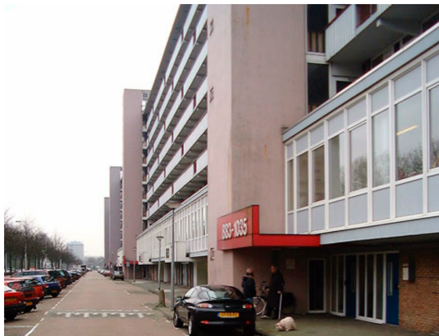
Bestaande situatie woningentree en gesloten plint op maaiveld niveau.
