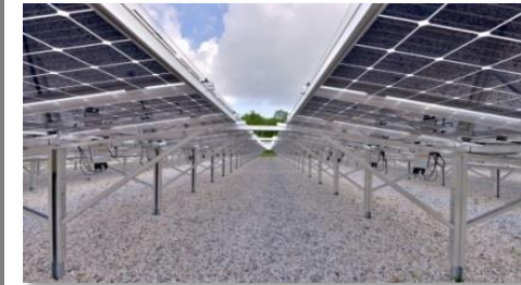
Tweezijdig werkende panelen bij Tempres (Vaassen, NL). Technologie: ECN, Tempres en Yingli.
