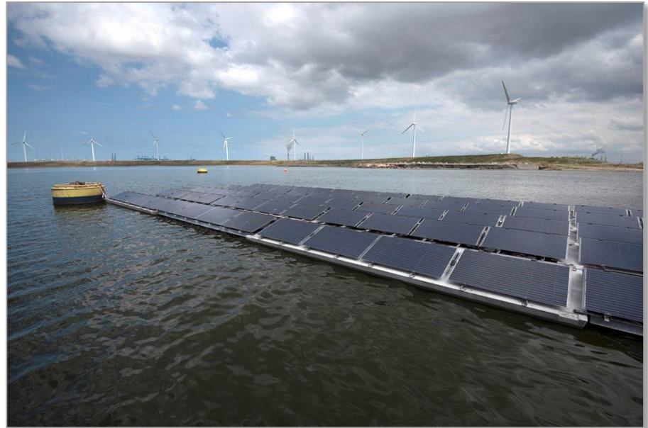
Testlocatie Nationaal Consortium Zon op Water, De Slufter, Maasvlakte, Rotterdam (systemen van Texel4Trading, wattco, SunProjects en Sunfloat)
