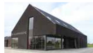
Project: voetbalaccommodatie SVA, Assendelft Ontwerper: Kuiper Steur Architecten BNA Opdrachtgever: Stichting Voetbal Accommodaties Assendelft Adviseurs: Brouwer&Kok Constructeurs Badhoevedorp, Advanced Engineering Zaandam, Adviesburo R.I.E.T Bunnik
