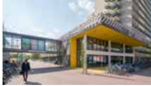
Project: Campus Uilenstede, Amstelveen Ontwerper: NEXT architects Opdrachtgever: Lingotto Vastgoed Ontwikkeling, DUWO studenten-huisvesting Adviseurs: Bouwadviesbureau Strackee; M-trix installatie-adviseurs; Bornia bouwadvies, Van Hooft en Partners
