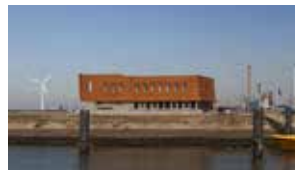
Project: Tendergebouw Loodswezen, IJmuiden Ontwerper: FARO architectuur, stedenbouw, research Opdrachtgever: Loodswezen IJmuiden, Jan Bregman Adviseurs: Lokhorst, Tentij, Nieman, Interplan
