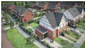
Project: 2/1 kapwoningen Reigersborg Noord fase 3c, Hoogkarspel Ontwerper: BBHD Architecten Opdrachtgever: ZeemanVastgoed Adviseurs: Zeeman Architecten
