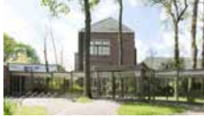
Project: De Oude Kerk, Heemstede Ontwerper: KPG architecten Opdrachtgever: Protestantse Gemeente Heemstede i.s.m. Stichting de Oude Kerk
