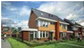
Project: 2/1 kapwoningen Unjerhof, Zwaag Ontwerper: Zeeman Architecten Opdrachtgever: ZeemanVastgoed Adviseurs: Zeeman Architecten
