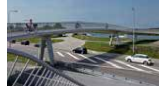
Project: fietsbrug N242, Heerhugowaard Ontwerper: ipv Delft Opdrachtgever: Gemeente Heerhugowaard Adviseurs: Ballast Nedam Infra, Pieters Bouwtechniek
