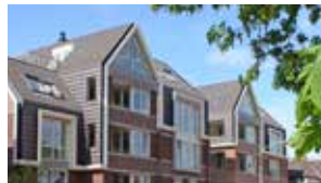
Project: Appartementen Wandelweg, Wormerveer Ontwerper: caas architecten Opdrachtgever: Wadi vastgoed bv Adviseurs: Berkhout Tros constructeur, BIMprojects Jasper van Baar, Koos Kruijer bouwmanagement, Hollands groen
