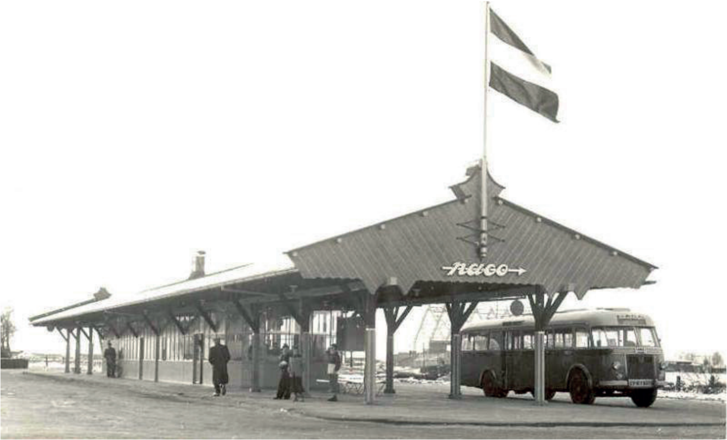
↑ DE KAPCONSTRUCTIE VAN HET BESTEANDE GEBOUW BLEEF BEHOUDEN
