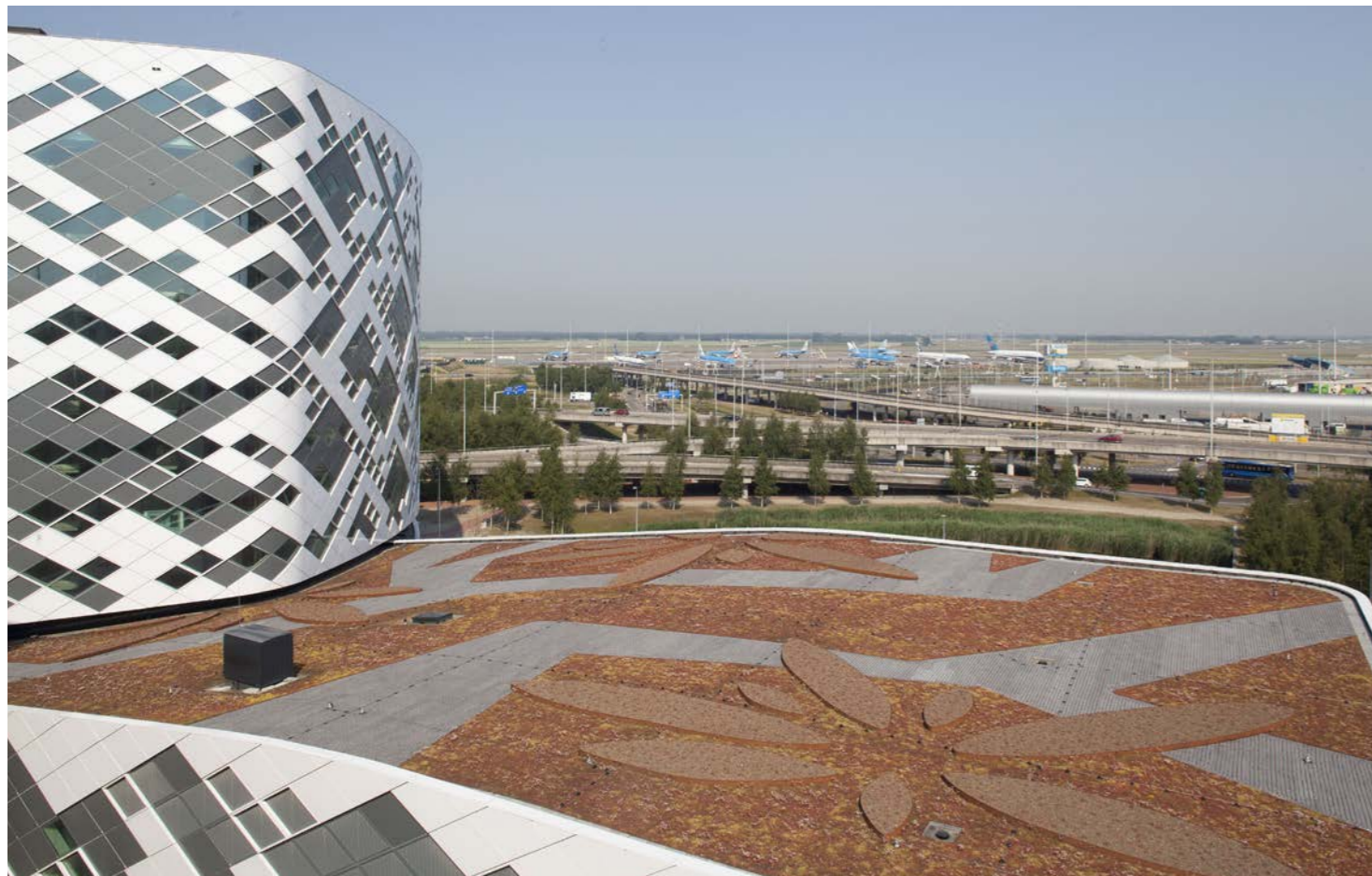
Het diagonale patroon van de gevel benadrukt het iconisch karakter van het gebouw
