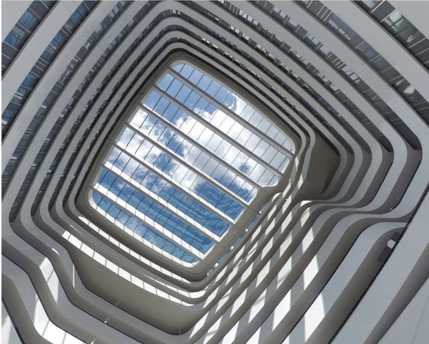
Het horizontale lijnenspel van de helderwitte balustrades brengen daglicht diep het gebouw in
