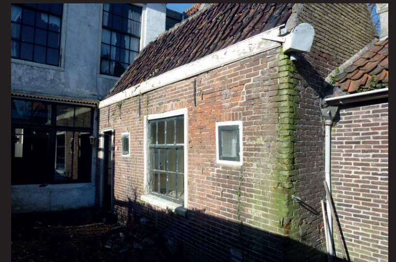
achtergevel met bestaande uitbouw
