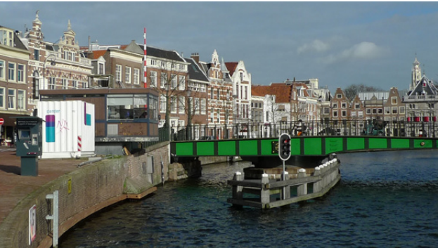
Situatie 2014 met brugwachtershuisje uit 1960
