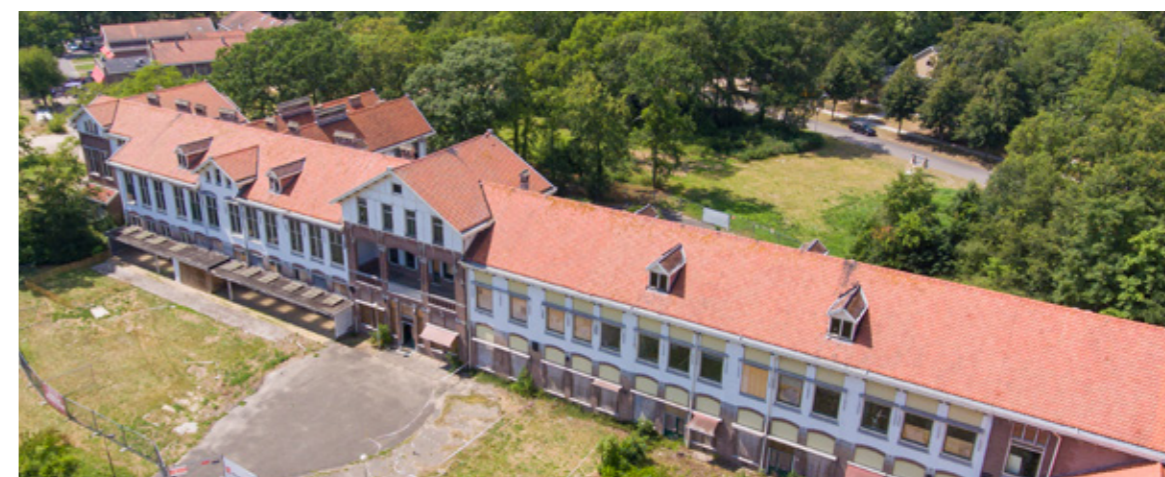
De rechter vleugel van het paviljoen was voor de renovatie al stevig versoberd tijdens een ingreep in de jaren 60. De linker vleugel heeft nog z'n originele dienstvertrekken aan de noordzijde.
